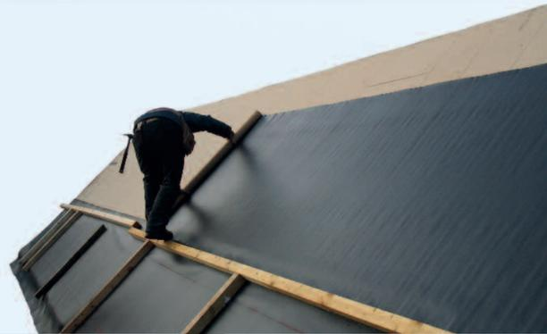
Veränderte klimatische Bedingungen aber auch konstruktiv bedingte Optimierung der Hinterlüftungsebene führen zu erhöhten Ansprüchen an die Temperaturstabilität und Alterungsbeständigkeit von diffusionsoffenen Unterdeckbahnen. Bestehende Produkte, wie bspw. PP Membranen, stoßen hier an ihre Grenzen. Mit der **CaTop XL Thermo** bieten wir nunmehr eine Ergänzungslösung zu der langjährig erfolgreichen CaTop XL.
